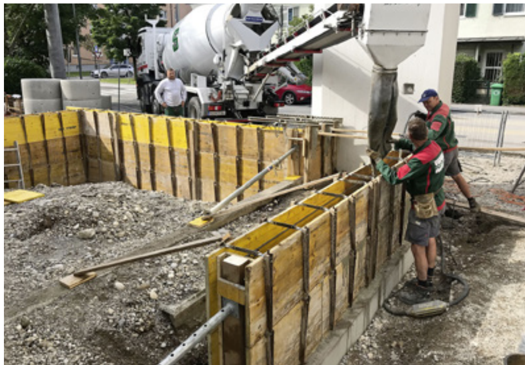
Der Platz zwischen Kirche und Gemeindehaus wird gebaut
